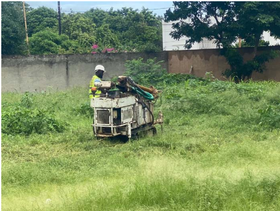
Figure 5 : Mise en station foreuse
